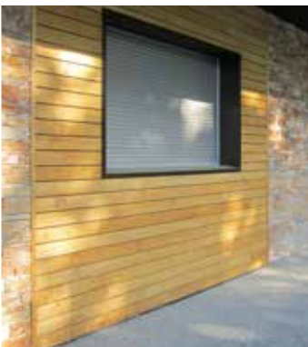
Bardage mixte (bois + parement pierre) pour la rénovation d'un bâtiment tertiaire
