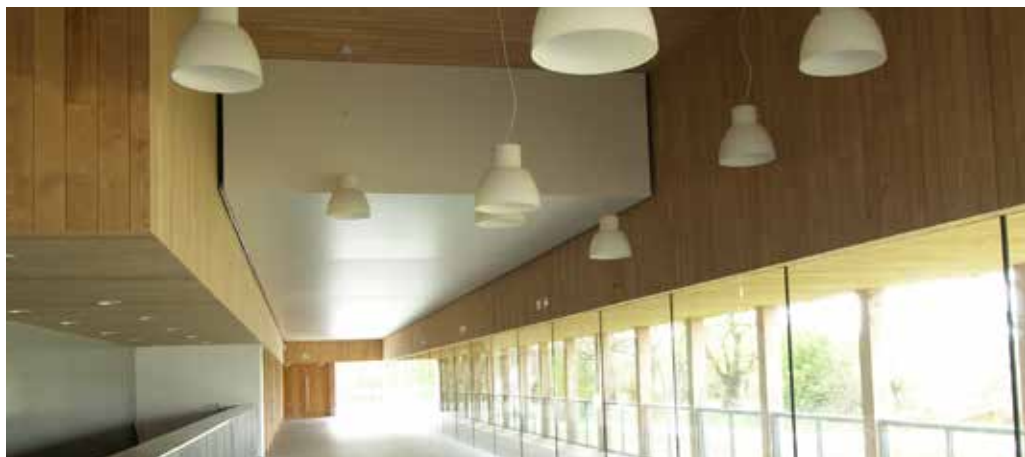
Des lames de châtaignier habillent les murs et les plafonds du hall d'accueil de la salle polyvalente A Cappella.
