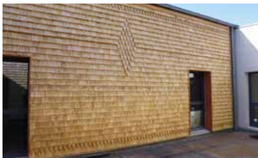
Bardeaux fendus, pose à recouvrement
