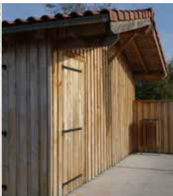
Bardage à recouvrement vertical
