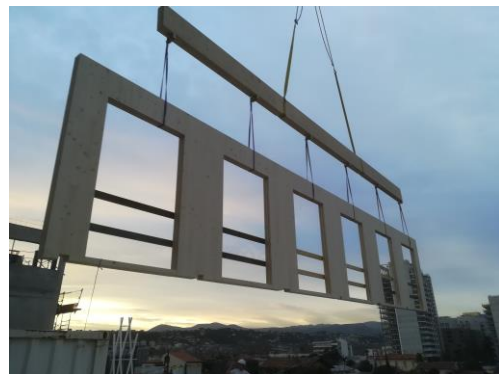
Exemple d'un levage à Nice
